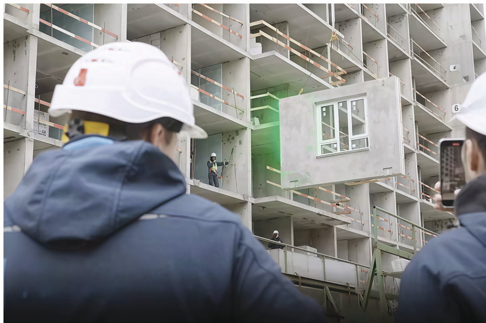
Блок с окном и есть та самая префаб-конструкция, с помощью которой так ускоряется строительство / СКРИНШОТ ВИДЕО КАНАЛА МЭРА МОСКВЫ В МЕССЕНДЖЕРЕ МАХ
