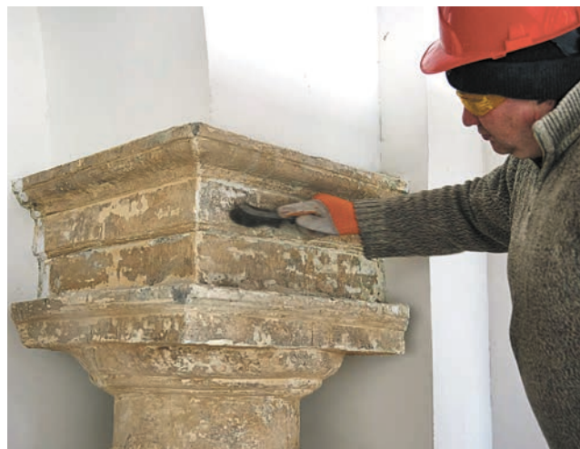
В Басманном районе продолжается преобразование Елоховского собора. Сейчас мастера восстанавливают дефекты штукатурки
