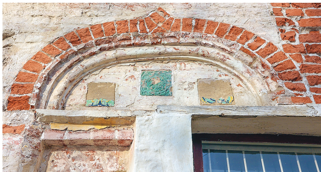
Николай Аввакумов слой за слоем снимал старую штукатурку, зная, что за ней кирпичная кладка XVII века, покрашенная в советское время / ЮРИЙ ФЕКЛИСТОВ
