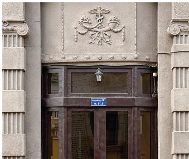
Благодаря каннелюрам даже массивные строения выглядят выразительнее / ФОНД КАПИТАЛЬНОГО РЕМОНТА МНОГОКВАРТИРНЫХ ДОМОВ МОСКВЫ
