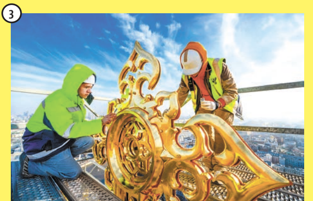
Ручная работа Восстановление декоративных элементов
