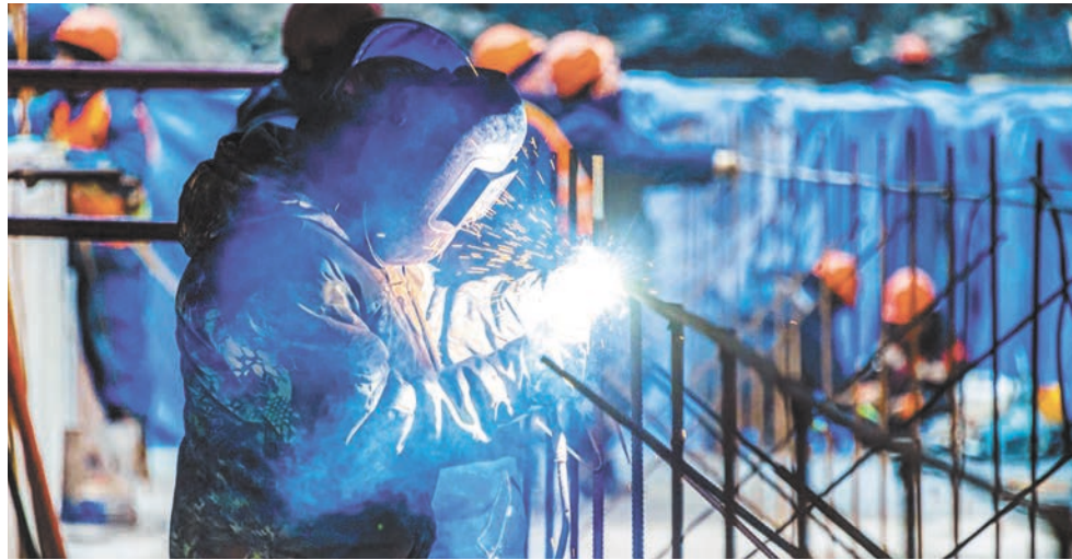
Специалисты подготавливают территорию для строительства / MOS.RU
