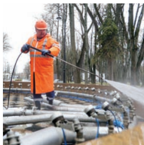
Очищение элементов фонтана идёт полным ходом / АГН «МОСКВА»
