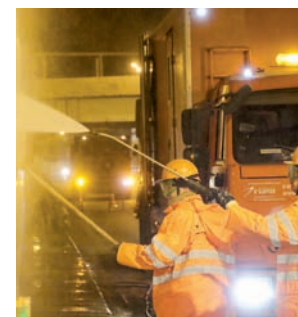
Тоннель отмывали специальным щелочным раствором / АГН «МОСКВА»
