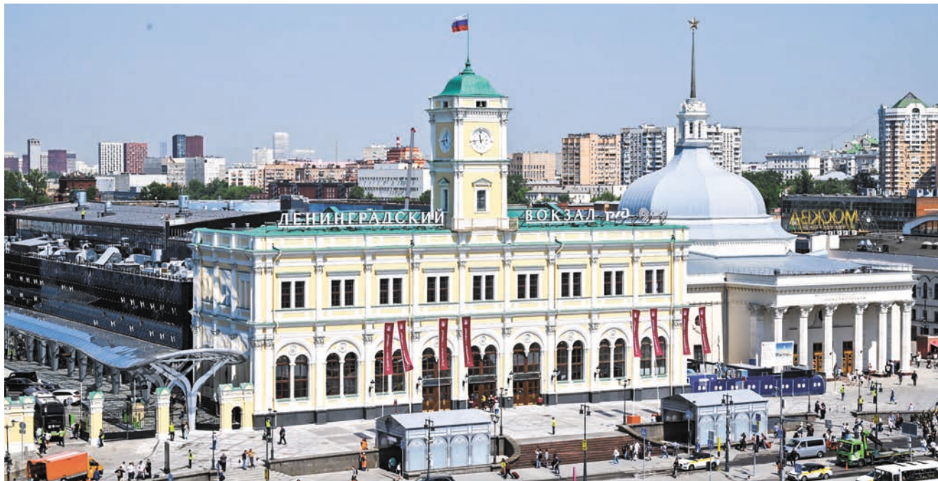
Историческую часть здания отреставрировали в соответствии с изначальным замыслом архитектора Константина Тона. В результате вокзал сохранил свой узнаваемый «открыточный» вид. По сравнению с последними годами появился флажок, где будет развеваться российский триколор / MOS.RU
