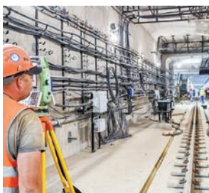
Завершить сооружение нового метро планируют в 2030 году / MOS.RU
