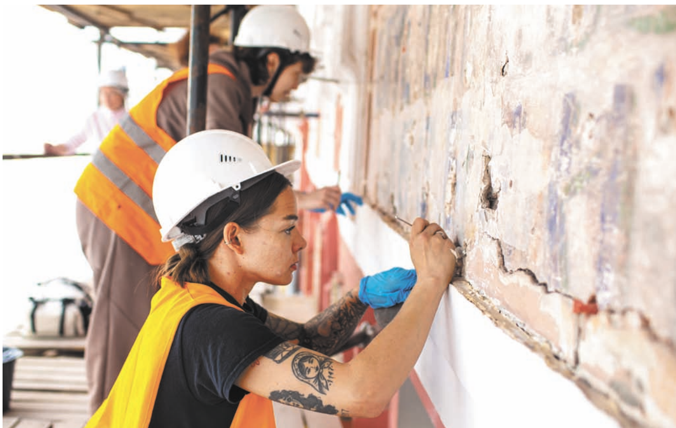
Реставраторы Татьяна и Екатерина (на переднем плане) за работой: очищать слой штукатурки надо аккуратно, чтобы ни один кусочек не вывалился / ОЛЬГА КАРАСЁВА
