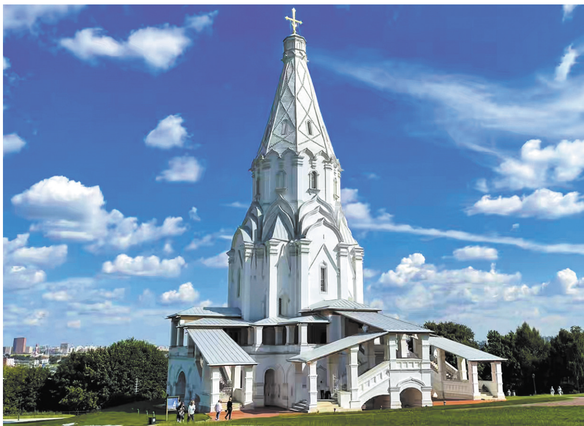
Высота храма – 62 метра – с двадцатипятиэтажный дом! Зодчие XVI века сотворили настоящее архитектурное чудо / СКРИНШОТ ВИДЕО / КАНАЛ МЭРА МОСКВЫ В МЕССЕНДЖЕРЕ «МАКС»
