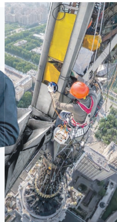
Для работы со стеклом используют специальные присоски – вакуумный захват
