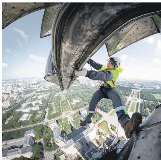
Подготовка поверхностей перед монтажом нового остекления
