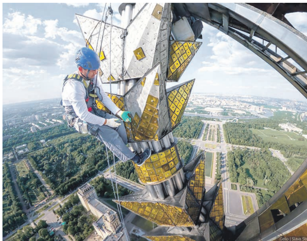
Промышленный альпинист демontiрует старое остекление / ВСЕ ФОТО: ТЕЛЕГРАМ-КАНАЛ SLAVASTEPANOV
