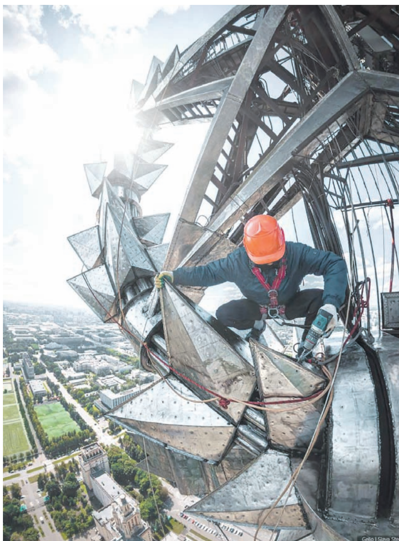
Металлический каркас уже готов. Следующий этап – установка жёлтых стёкол
